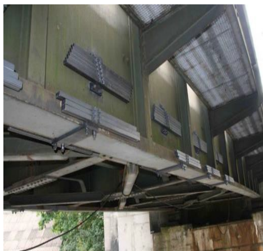
Figure 18: Absorbeur sur platelage
