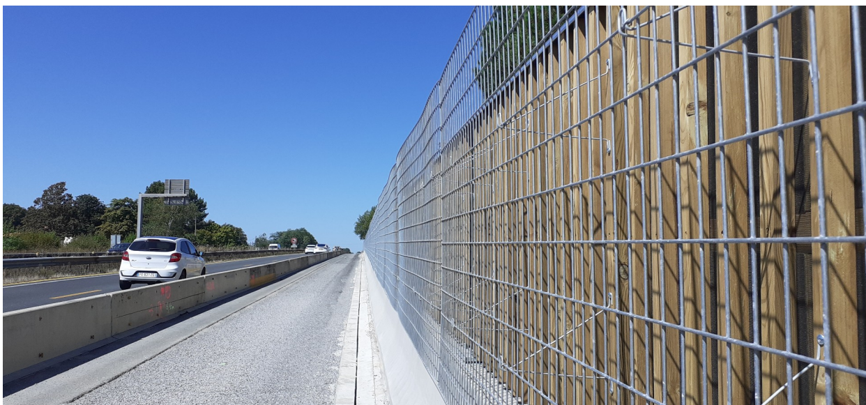
Figure 10 : Protection acoustique construit en 2023 sur la RN 89- commune de Beychac-et-Caillau
