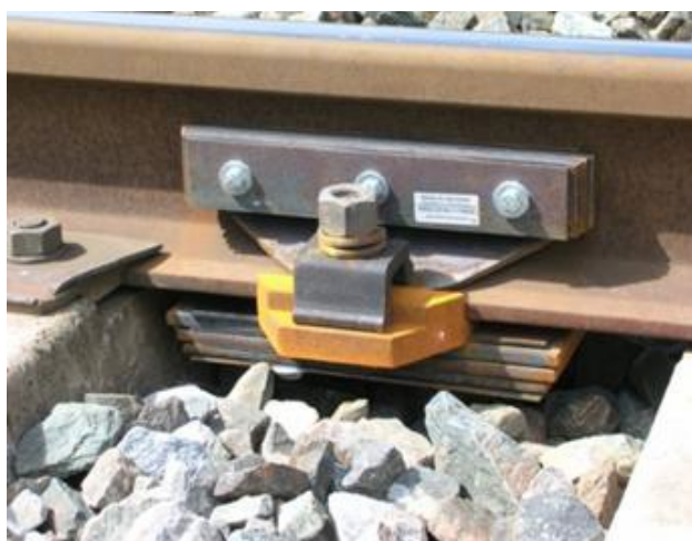
Figure 19: Absorbeur sur rail
