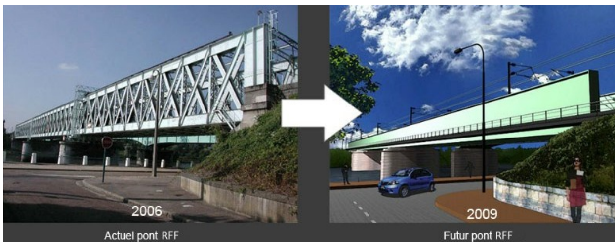
Figure 14: Exemple de changement de pont métallique à Oissel
