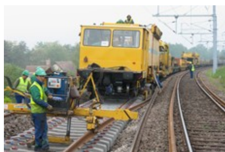
Figure 13: Longs Rails soudés sur traverses béton
